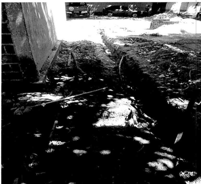
Imagem 03 – Abertura de Vala para caminhamento do Esgoto
