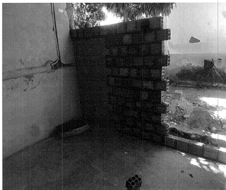
Imagem 02 – Levantamento de Alvenaria a meia altura
