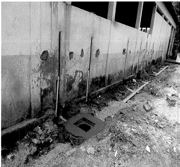
Imagem 05 – Instalações de Água Fria para locação de pias
