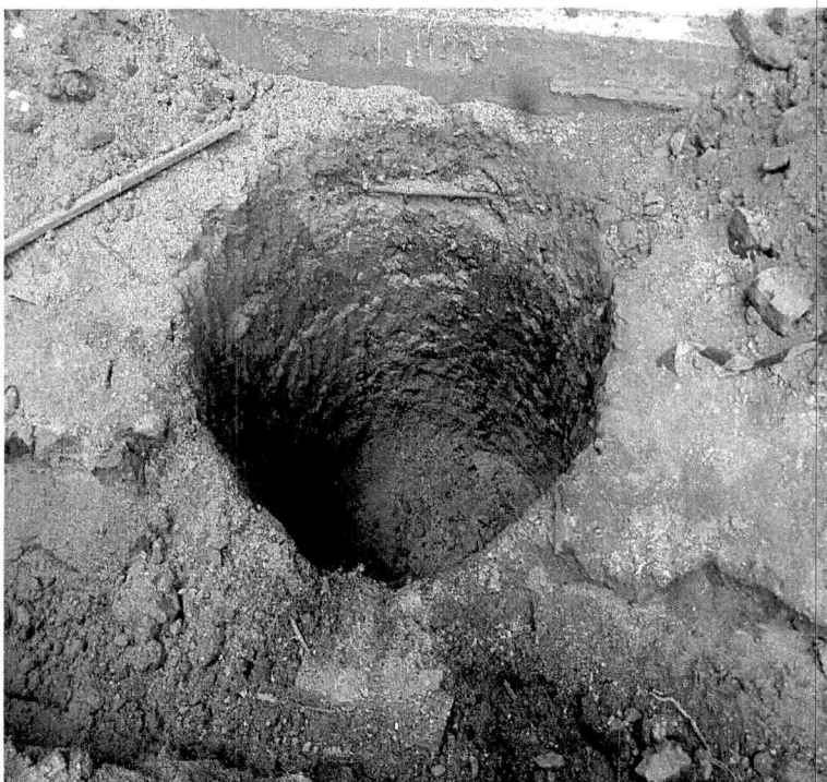
Imagem 06 – Execução de Fossa Séptica
