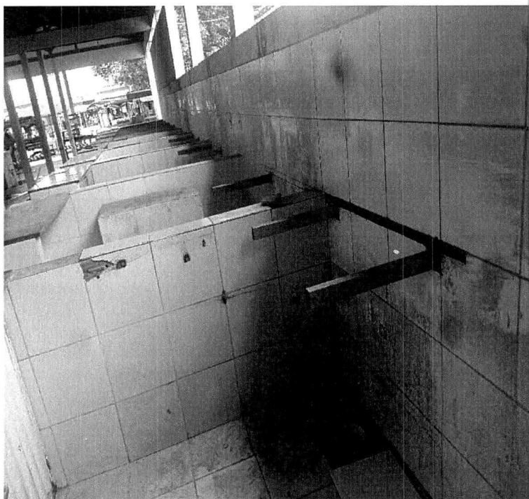
Imagem 07 – Implantação de basa para locação de pias
