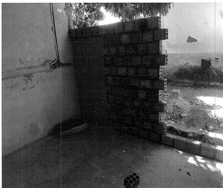
Imagem 02 – Levantamento de Alvenaria a meia altura
