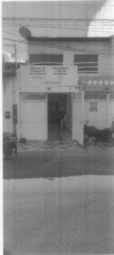
Fachada Fonte: Acervo Técnico (2021)
