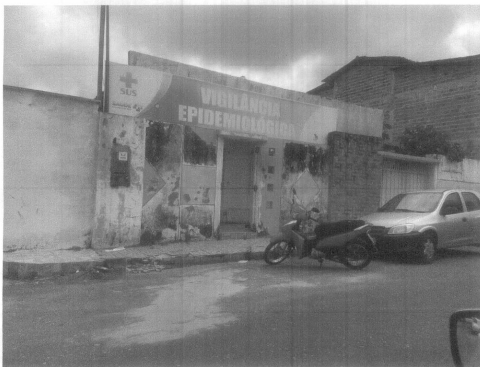
CENTRO EPIDEMIOLÓGICO, RUA CUNHA MACHADO, Nº 421, BAIRRO: CENTRO
