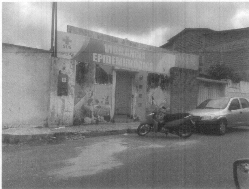
Fachada Fonte: Acervo Técnico (2021)
