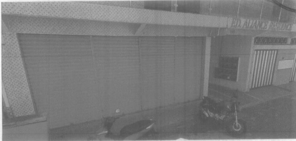
Fachada Fonte: Acervo Técnico (2023)
