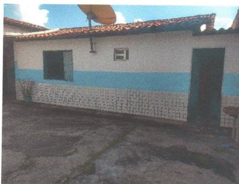
*Imagem 06 – contra piso pátio, pintura e telhado danificada.*
