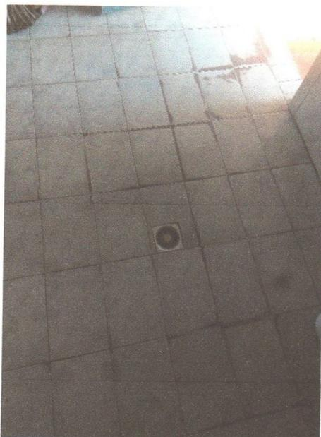
*Imagem 12 – revestimento cerâmico danificada.*
