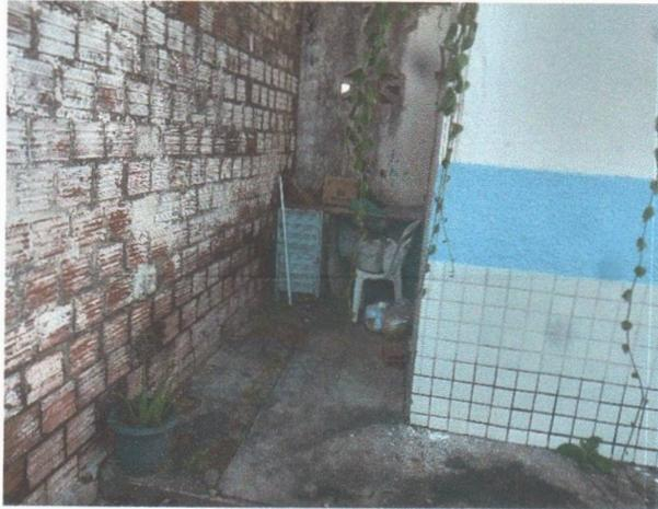
*Imagem 08 – calçada interna e instalações hidráulica danificada.*
