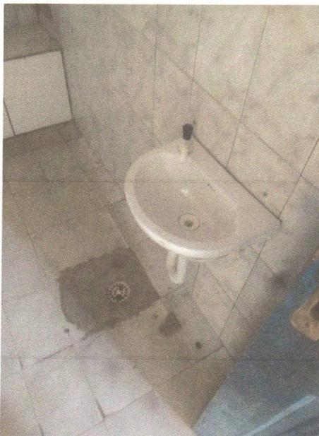
*Imagem 12 – revestimento cerâmico danificada.*
