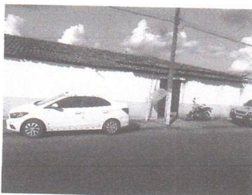
Imagem 02 – pintura muro externo danificada
