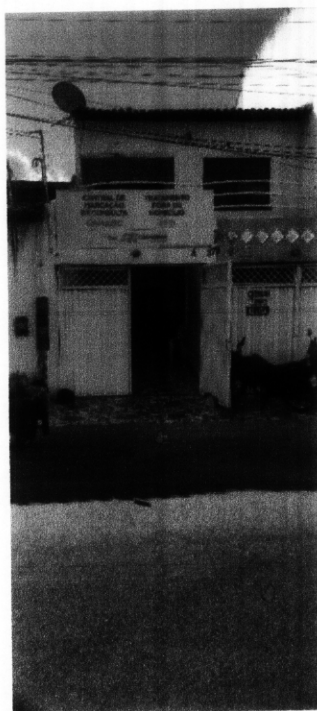
CENTRAL DE MARCAÇÃO DE CONSULTAS, AV. RODOVIÁRIA, Nº 379, BAIRRO: CENTRO
