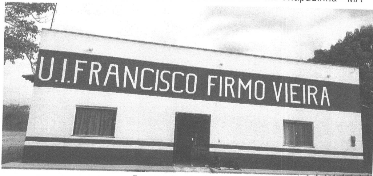
Foto 01: Vista frontal da escola
