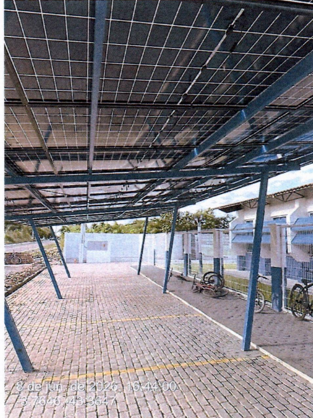
Imagem 27 – Estrutura metálica de estacionamentos
