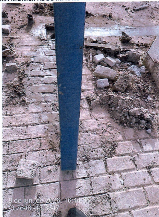
Imagem 26 – Estrutura metálica de estacionamentos
