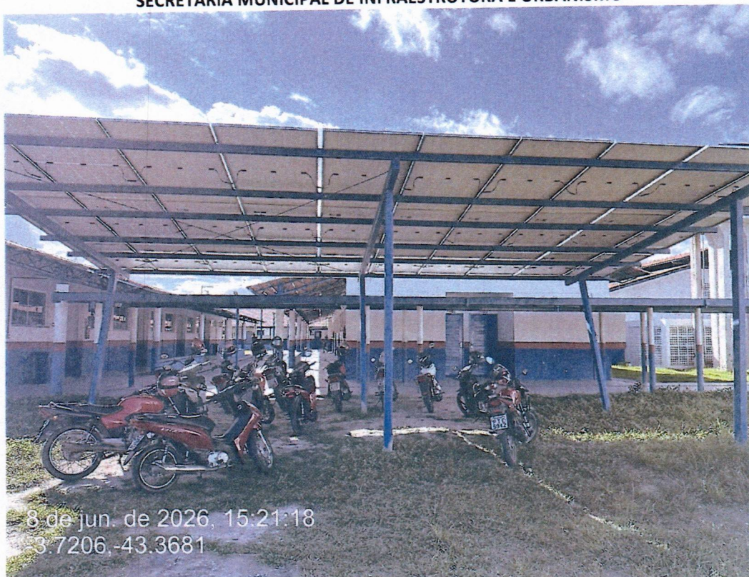
Imagem 10 – Estrutura metálica de estacionamentos
