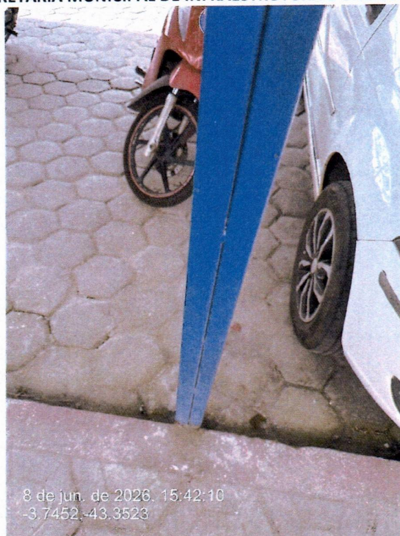
Imagem 04 – Estrutura metálica de estacionamento
