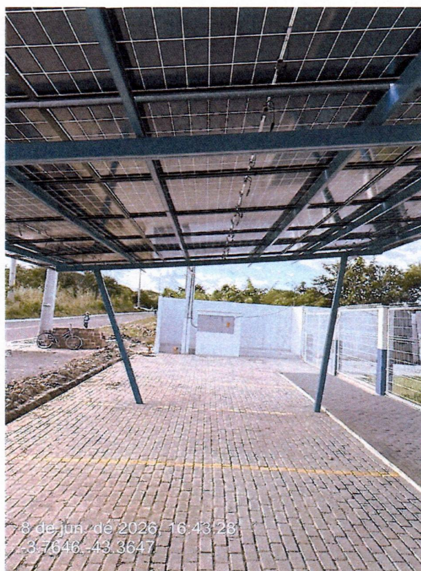
Imagem 29 – Estrutura metálica de estacionamento
