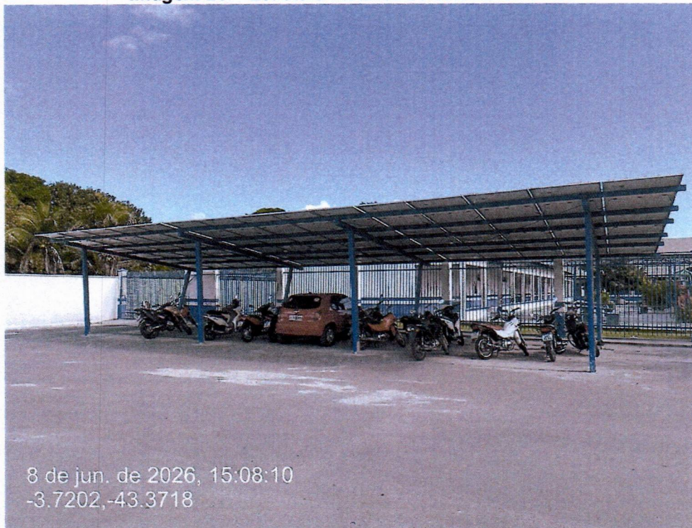
Imagem 21 – Estrutura metálica de estacionamentos
