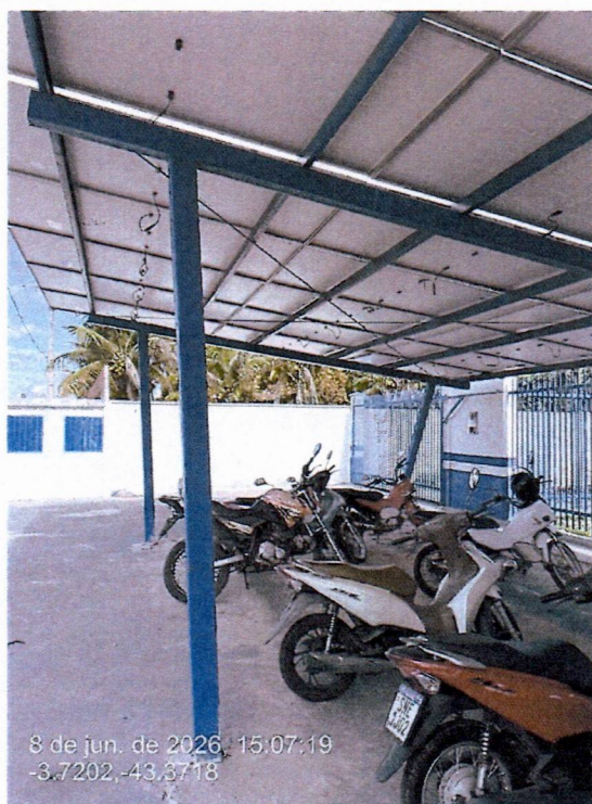
Imagem 17 – Estrutura metálica de estacionamentos
