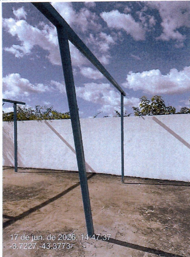
Imagem 36 – Estrutura metálica de estacionamento
