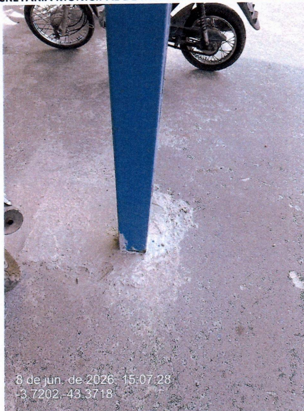
Imagem 18 – Estrutura metálica de estacionamentos
