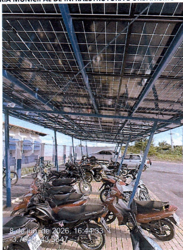
Imagem 30 – Estrutura metálica de estacionamentos
