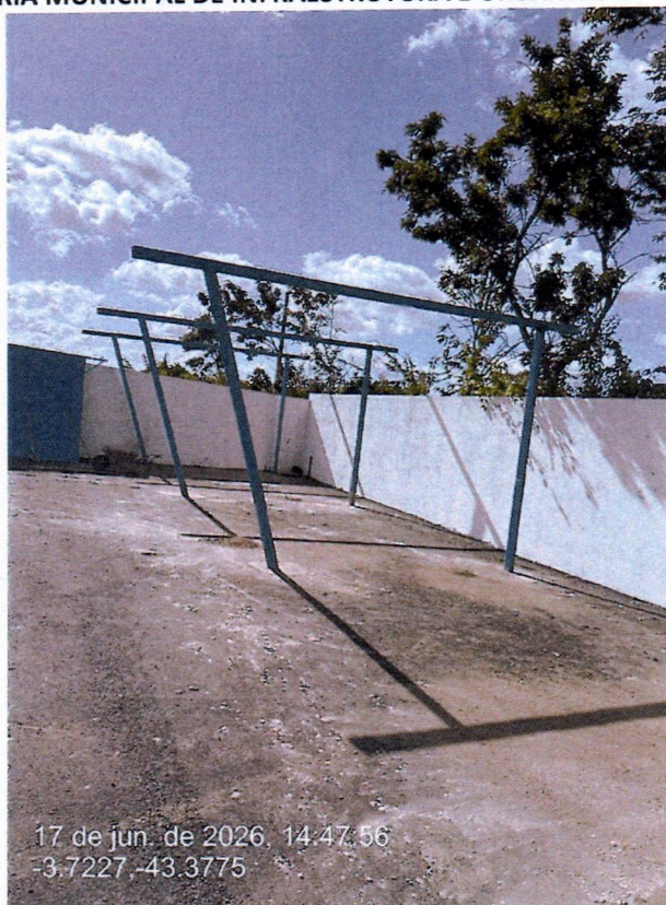
Imagem 32 – Estrutura metálica de estacionamentos
