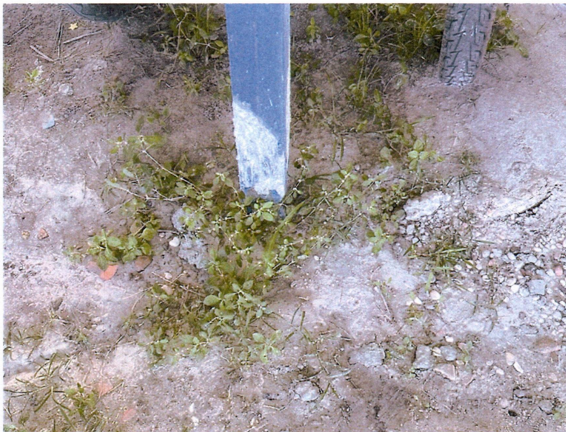
Imagem 09 – Estrutura metálica de estacionamento
