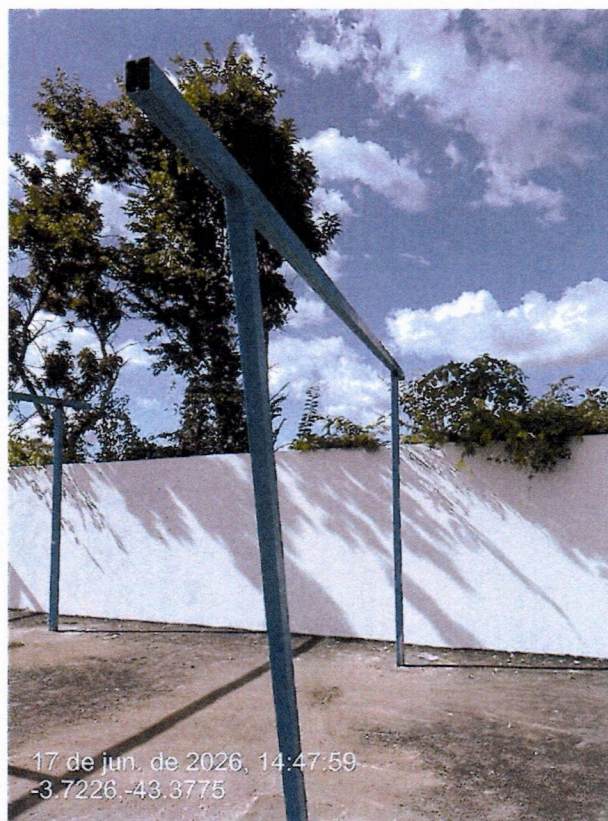
Imagem 31 – Estrutura metálica de estacionamentos
