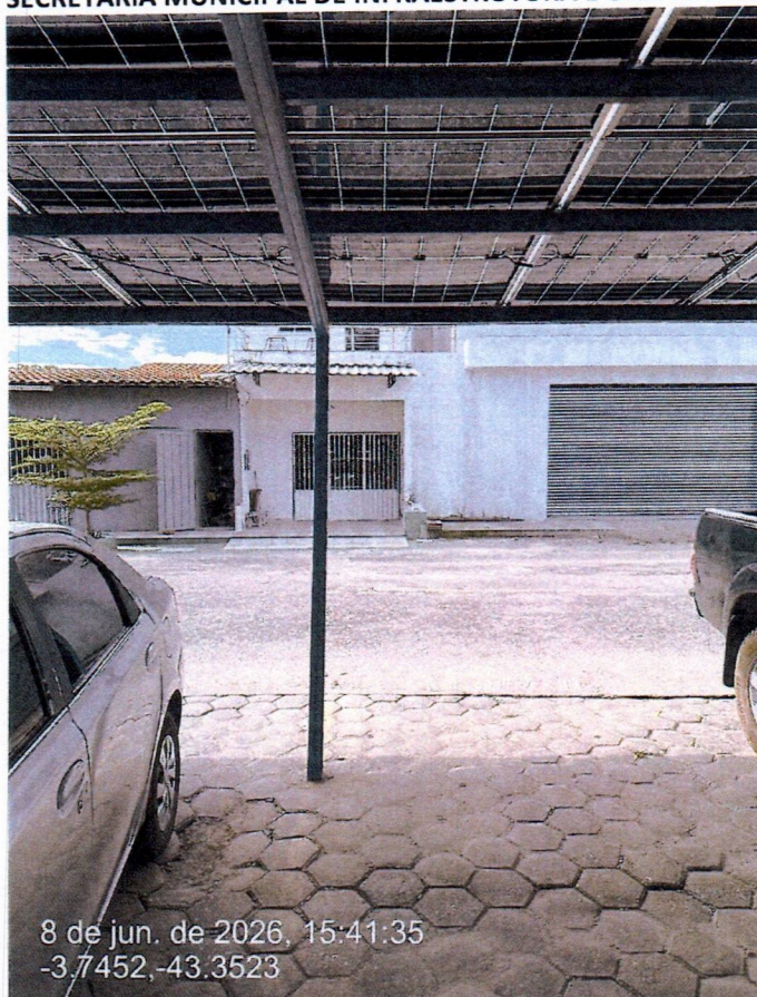
Imagem 02 – Estrutura metálica de estacionamentos
