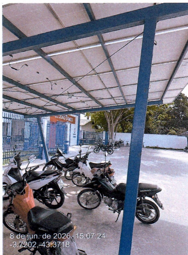
Imagem 19 – Estrutura metálica de estacionamentos
