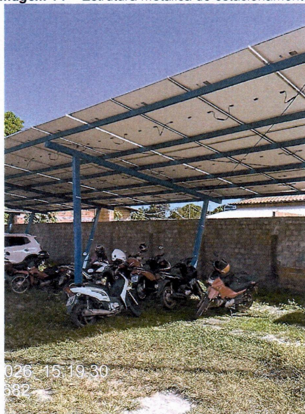
Imagem 15 – Estrutura metálica de estacionamentos
