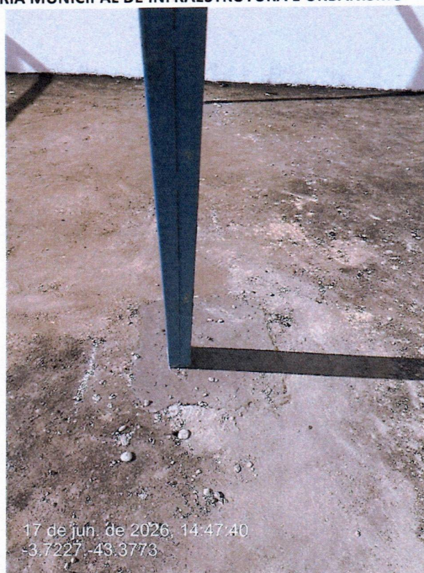
Imagem 34 – Estrutura metálica de estacionamentos
