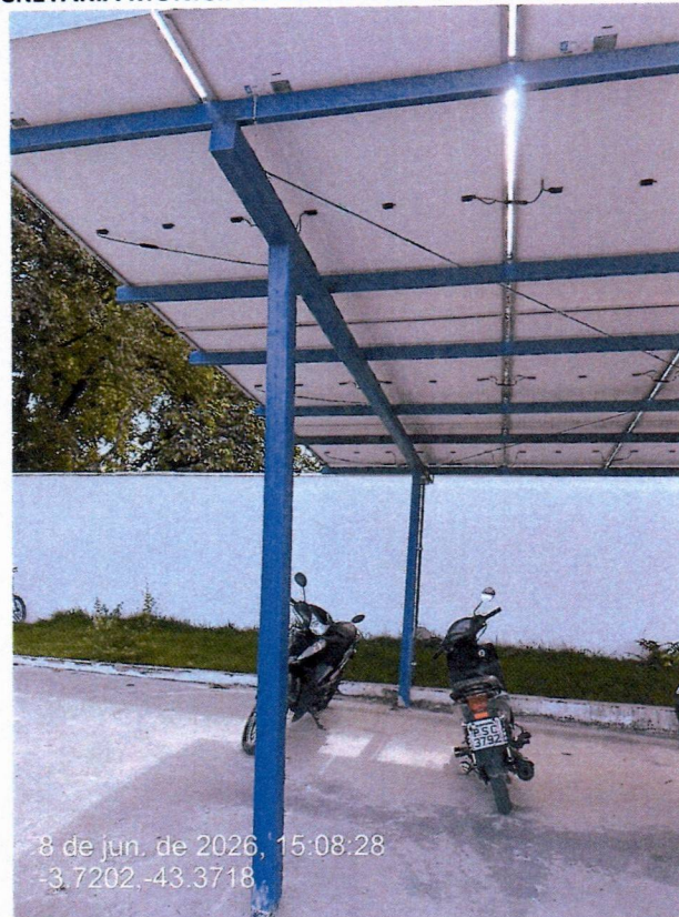
Imagem 20 – Estrutura metálica de estacionamentos
