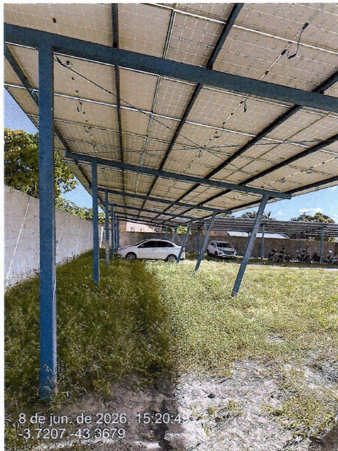
Imagem 11 – Estrutura metálica de estacionamentos
