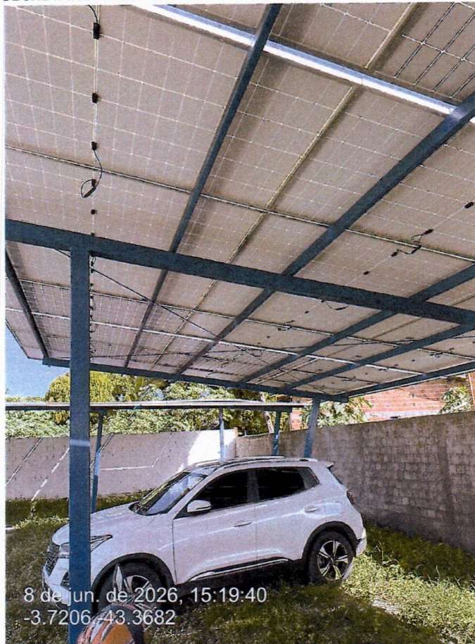
Imagem 16 – Estrutura metálica de estacionamentos
