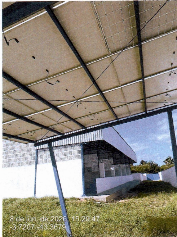
Imagem 12 – Estrutura metálica de estacionamentos
