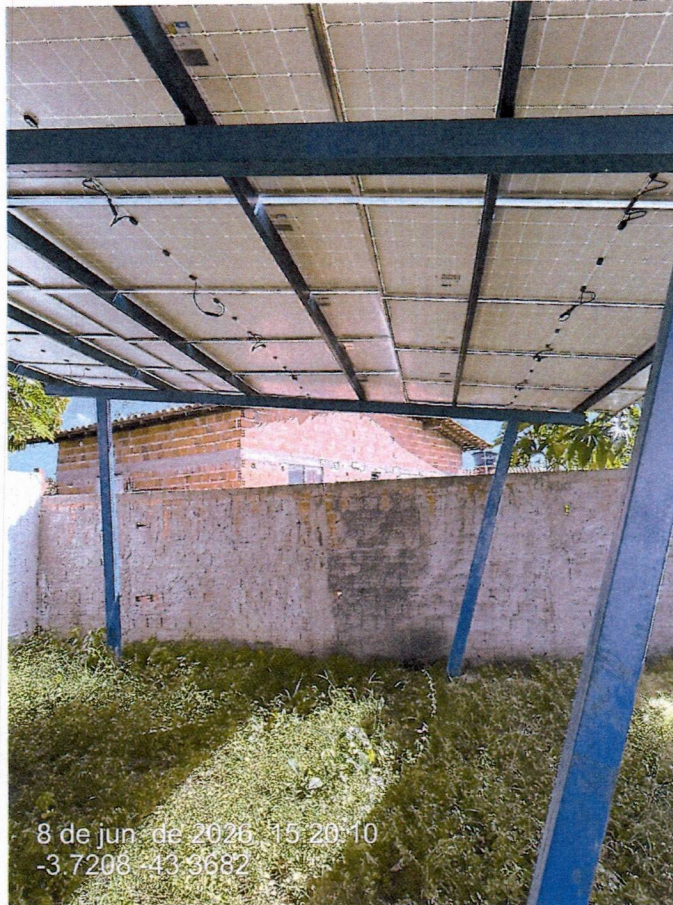
Imagem 14 – Estrutura metálica de estacionamentos
