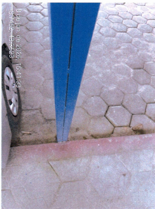
Imagem 01 – Estrutura metálica de estacionamentos
