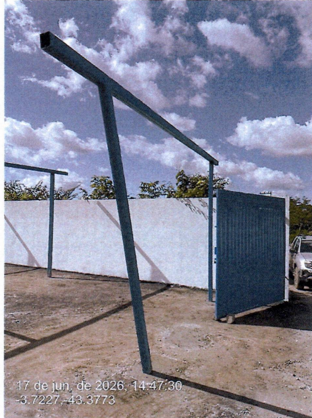
Imagem 35 – Estrutura metálica de estacionamentos
