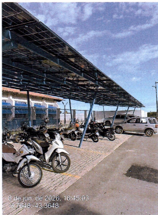
Imagem 25 – Estrutura metálica de estacionamentos
