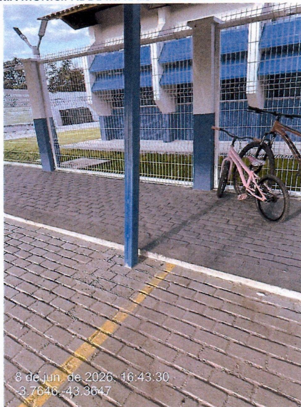
Imagem 28 – Estrutura metálica de estacionamento
