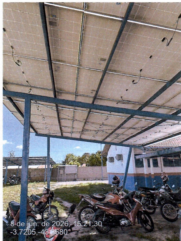
Imagem 13 – Estrutura metálica de estacionamentos
