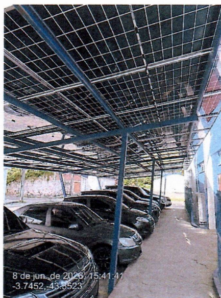
Imagem 03 – Estrutura metálica de estacionamentos
