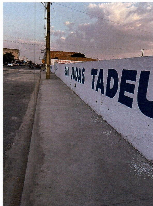
Imagem 05 – Execução de construção de Calçada
