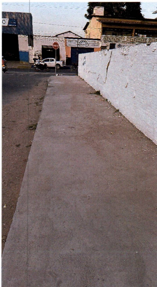
Imagem 01 – Execução de construção de Calçada
