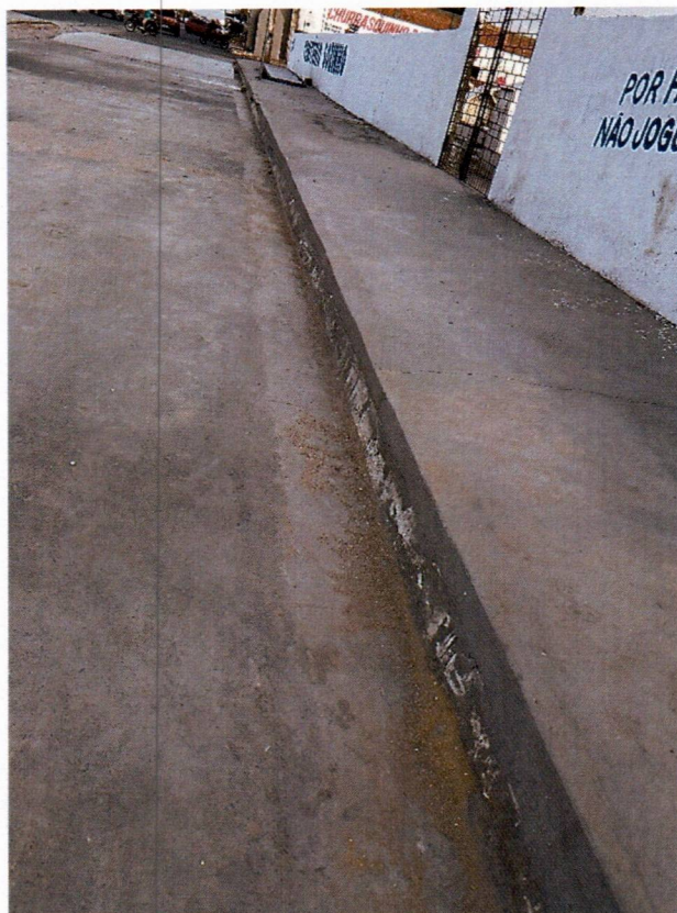
Imagem 06 – Execução de construção de Calçada
