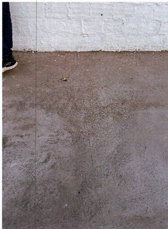
Imagem 03 – Execução de construção de Calçada
