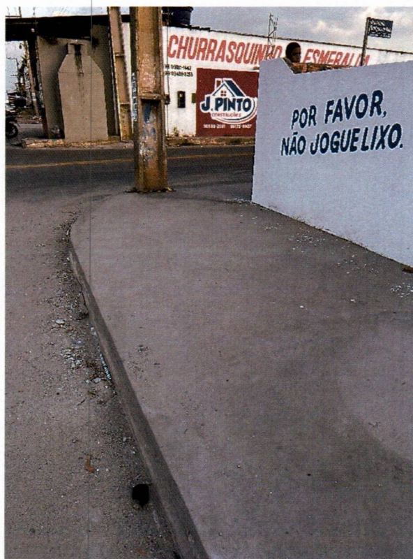
Imagem 07 – Execução de construção de Calçada
