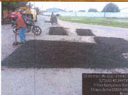
EXECUÇÃO DE TAPA BURACO
