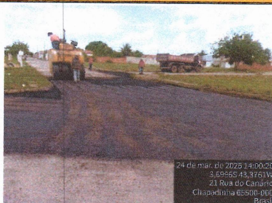
EXECUÇÃO DE TAPA BURACO
