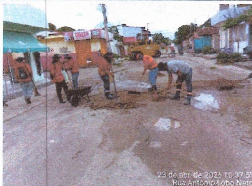
EXECUÇÃO DE TAPA BURACO
