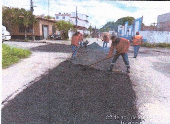
EXECUÇÃO DE TAPA BURACO
