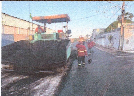
EXECUÇÃO DE IMPLANTAÇÃO ASFÁLTICA - ASFALTO
