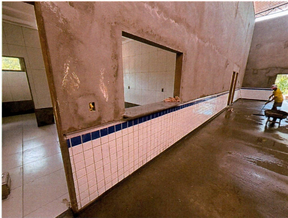
Imagem 8 – Execução do revestimento 10x10 no pátio.
