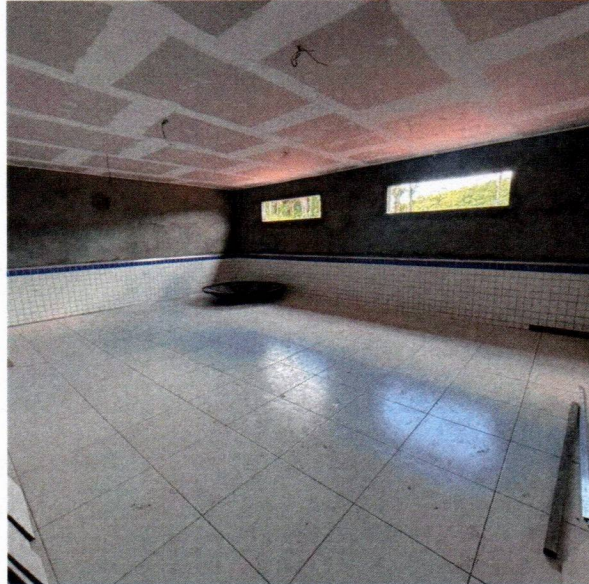
Imagem 06 – Serviços de revestimentos cerâmicos e forro
