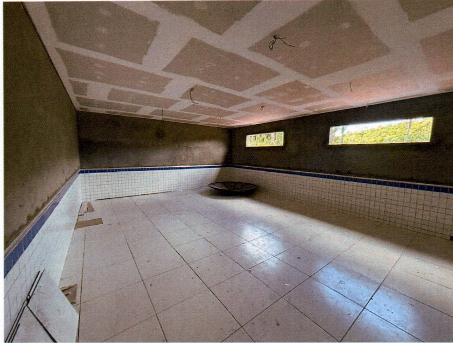
Imagem 7 – Execução do revestimento 10x10 nas salas e execução do forro acartonado.
