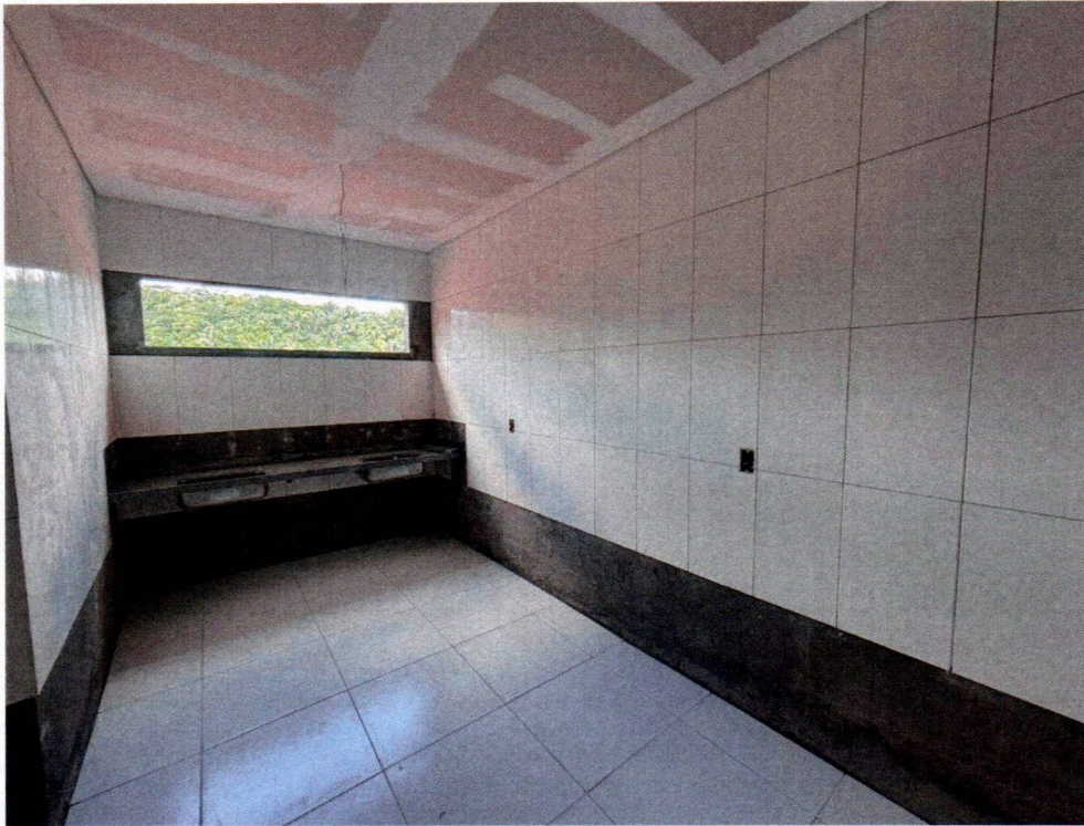
Imagem 08 – Serviços de revestimentos cerâmicos e forro
