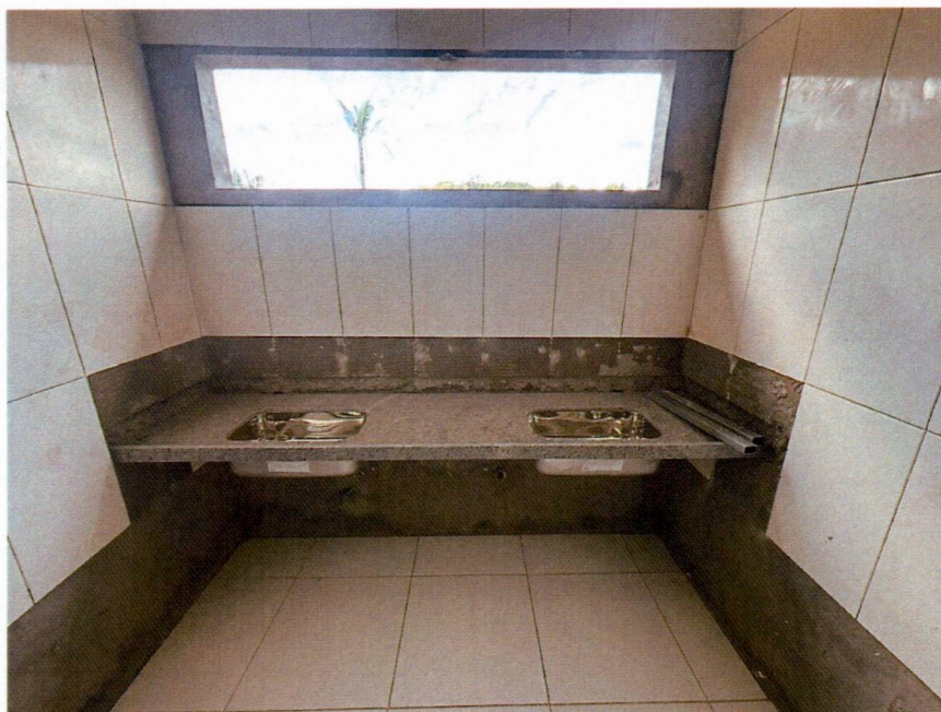
Imagem 11 – Execução do revestimento cerâmico da cozinha e assentamento das bancadas em granito.
