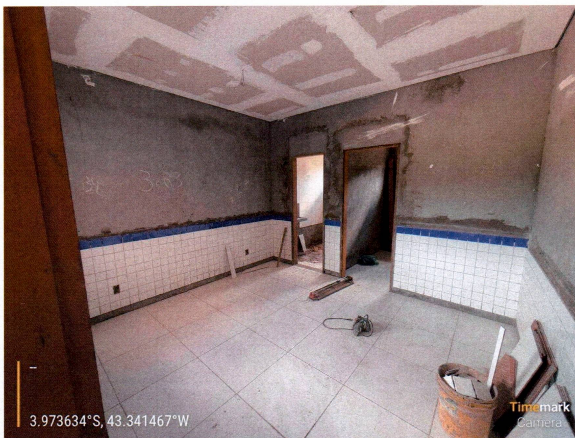
Imagem 01 – Serviços de Revestimentos cerâmicos
