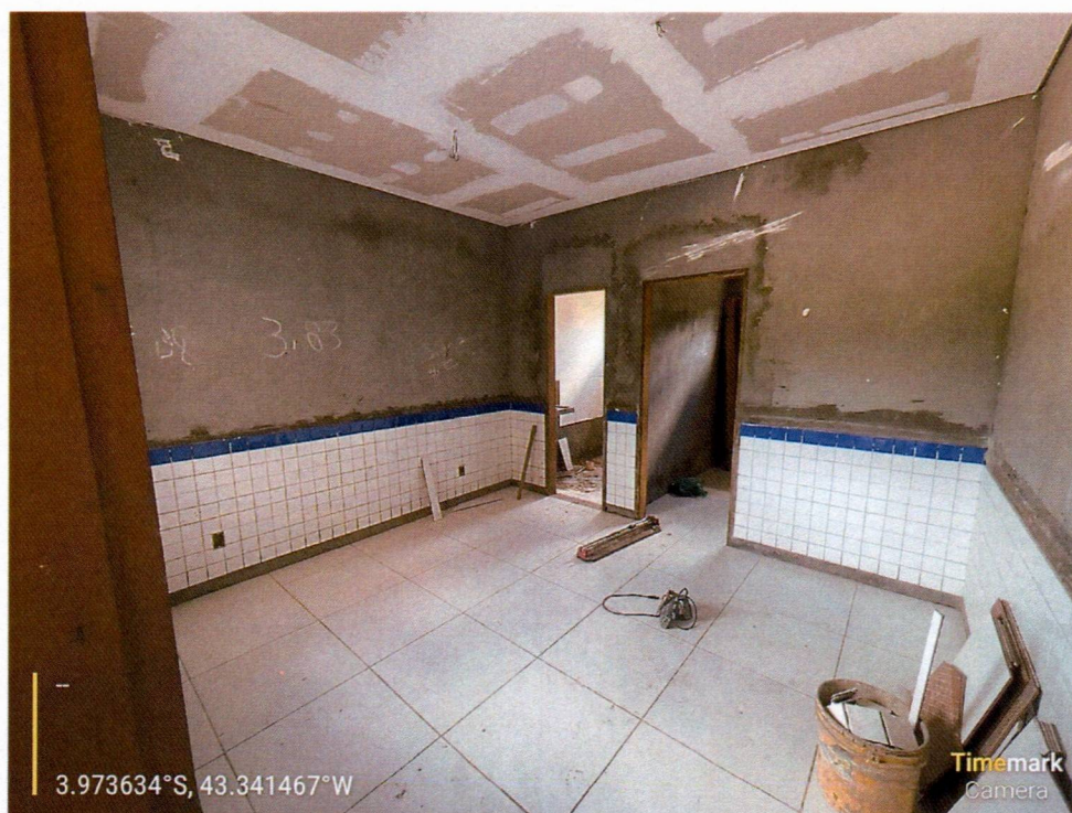
Imagem 6 – Execução do revestimento 10x10 nas salas e execução do forro acartonato.
