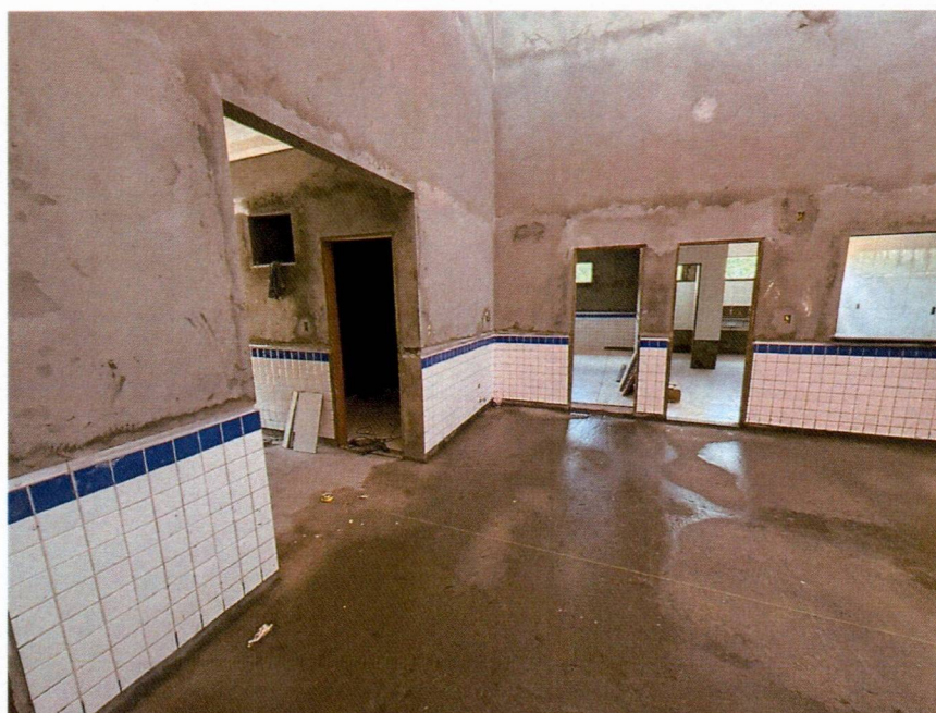
Imagem 4 – Execução do revestimento 10x10 nas paredes.
