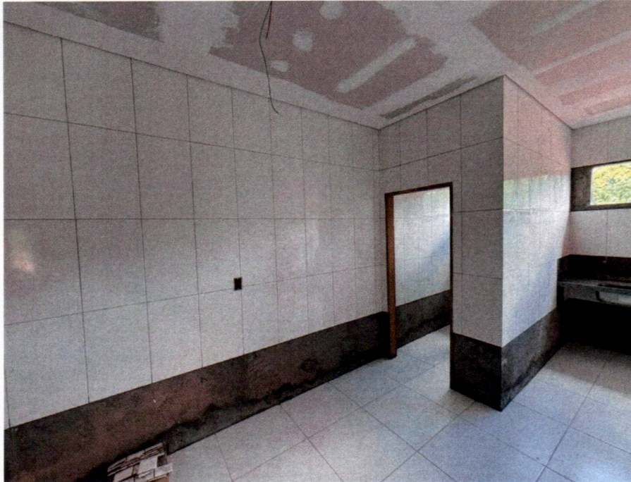
Imagem 10 – Serviços de revestimentos cerâmicos e forro
