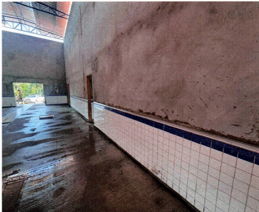
Imagem 05 – Serviços de contrapiso e revestimento cerâmico
