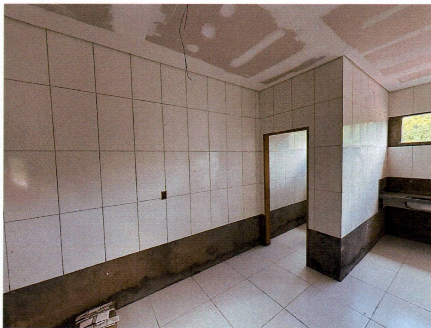
Imagem 10 – Execução do revestimento cerâmico da cozinha.
