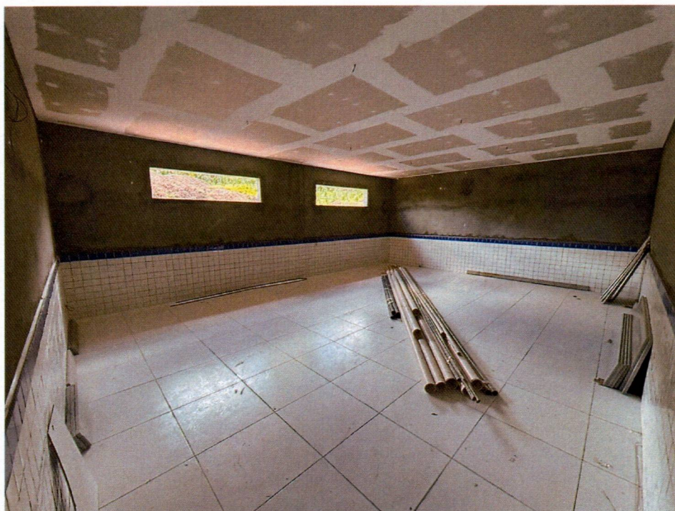
Imagem 5 – Execução do revestimento 10x10 nas salas e execução do forro acartonato.
