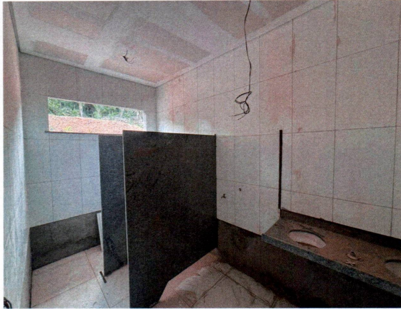
Imagem 12 – Serviços divisórias de granito, louça e metais
