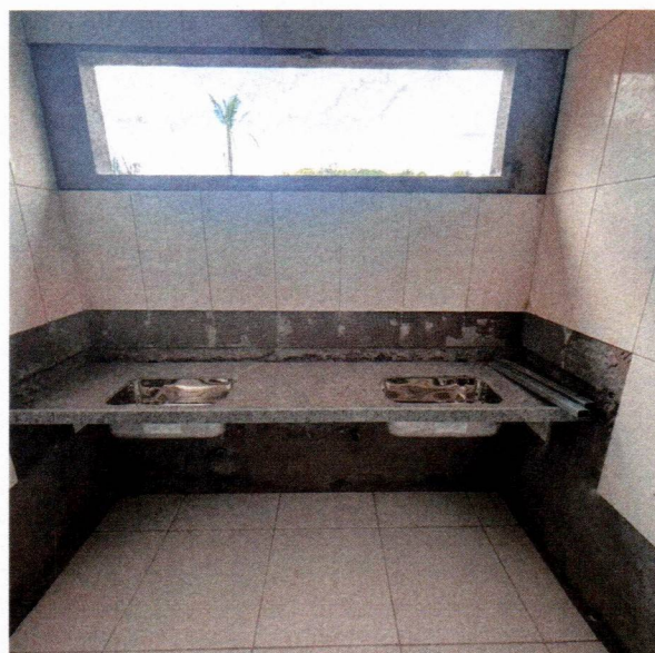
Imagem 09 – Serviços de revestimentos cerâmicos louça e granito
