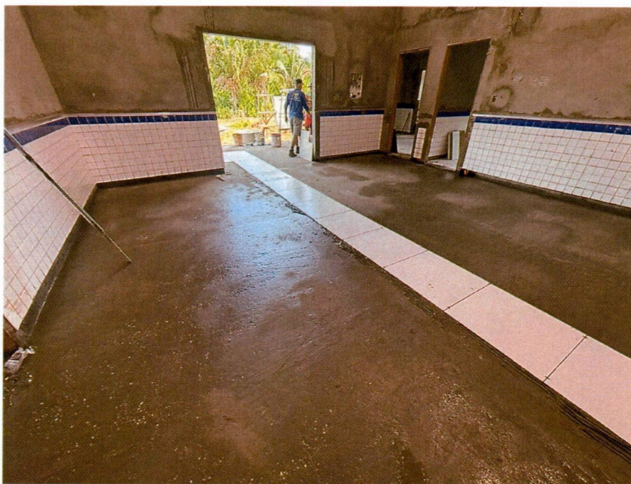
Imagem 1 – Execução do revestimento cerâmico do patio da escola e revestimento 10x10 nas paredes.
