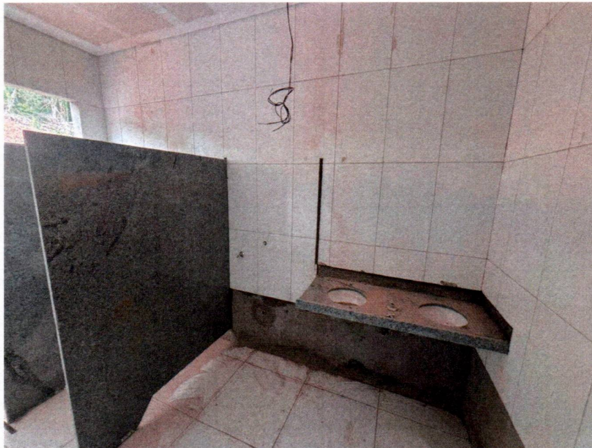
Imagem 13 – Serviços divisórias de granito, louça e metais
