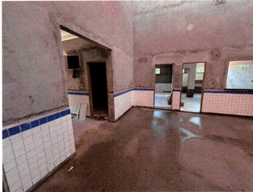
Imagem 04 – Serviços de piso de concreto
