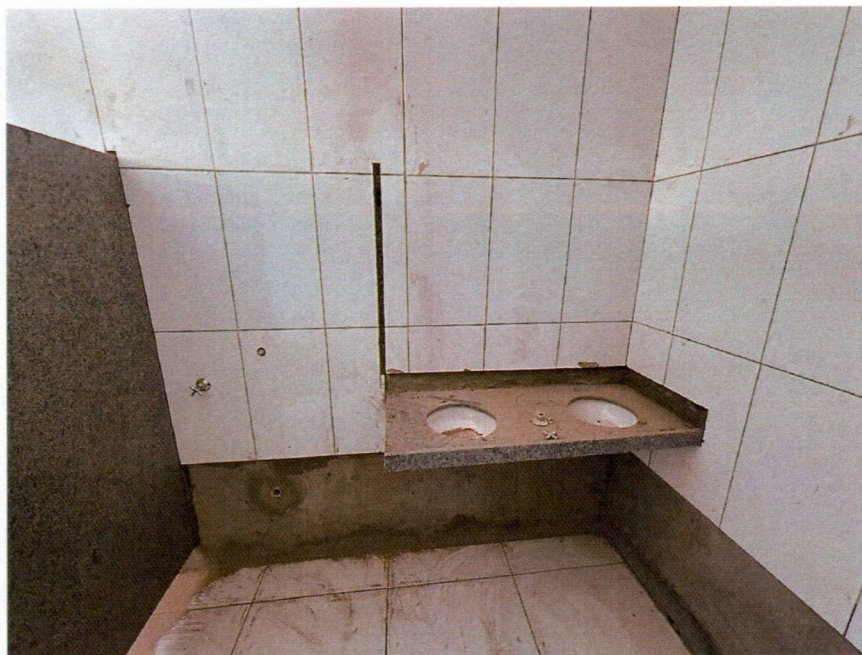
Imagem 13 – Execução do revestimento cerâmico dos banheiros e assentamento das bancadas de granito dos banheiros.
