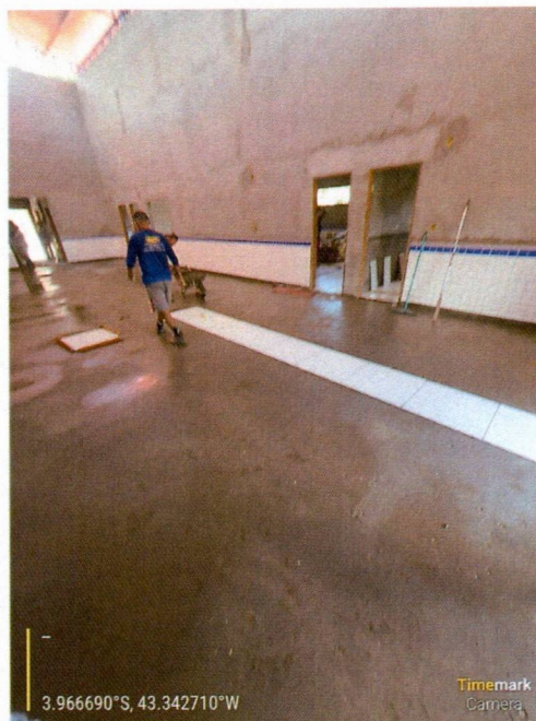
Imagem 3 – Execução do revestimento cerâmico do patio da escola e revestimento 10x10 nas paredes.
