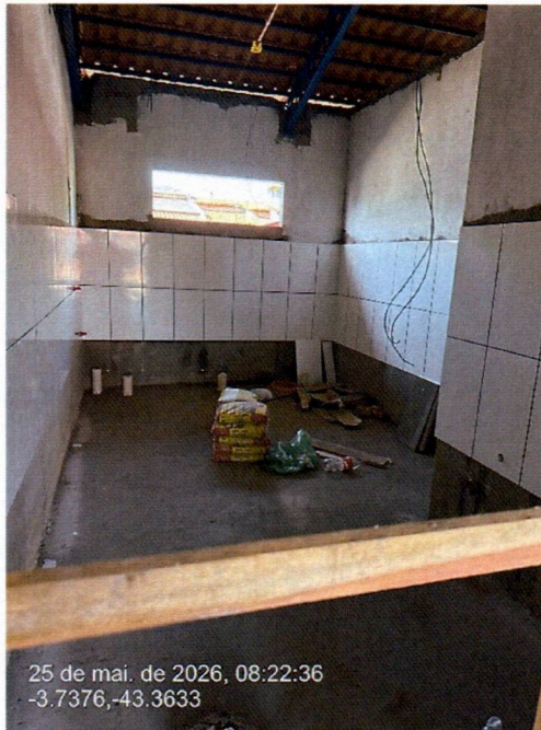
Imagem 9 – Execução do revestimento cerâmico dos banheiros.
