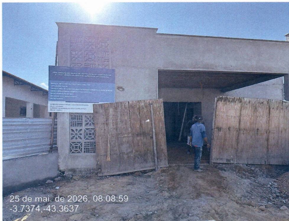
Imagem 07 – Serviços de alvenaria, estrutura e chapisco
