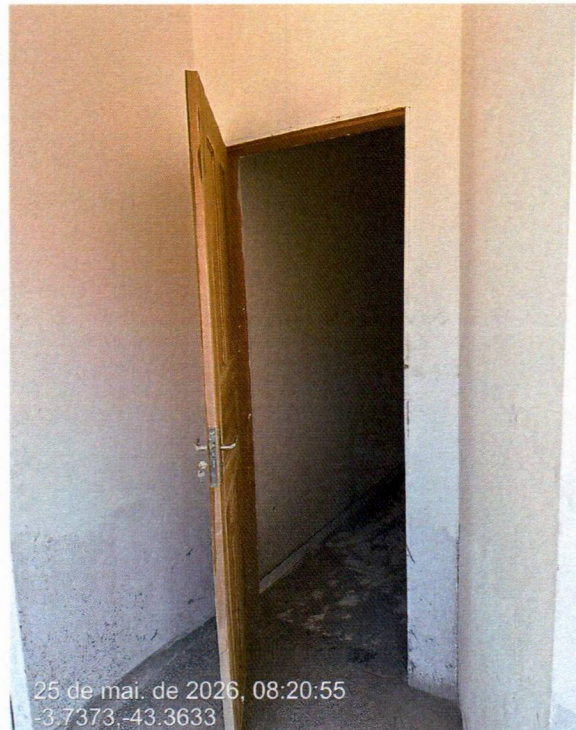
Imagem 09 – Serviços de esquadrias de madeira
