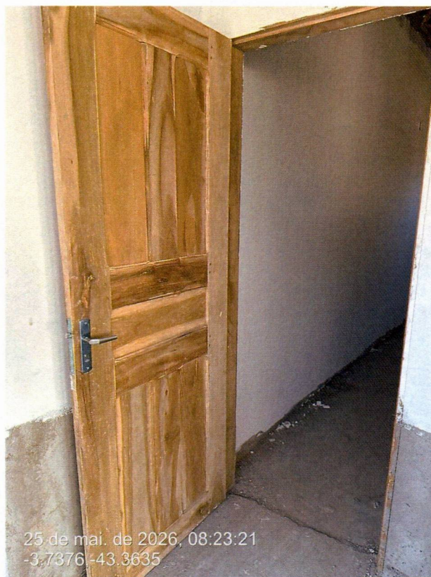
Imagem 11 – Serviços esquadrias de madeira
