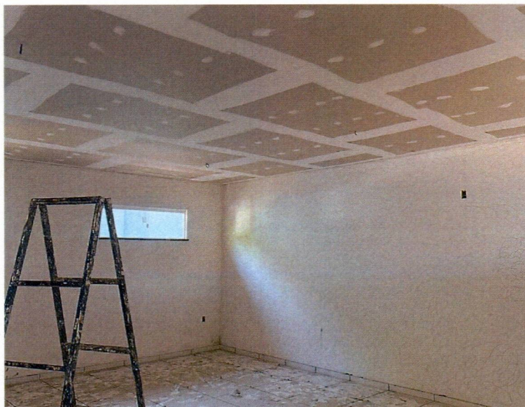
Imagem 15 – Serviços de pintura e revestimentos cerâmicos
