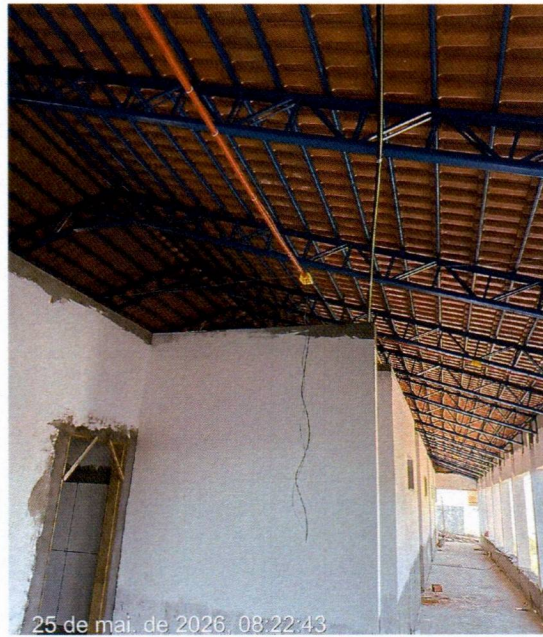
Imagem 06 – Serviços de cobertura em telha cerâmica
