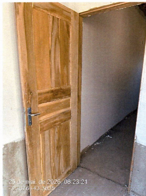
Imagem 8 – Instalação das portas de madeira.
