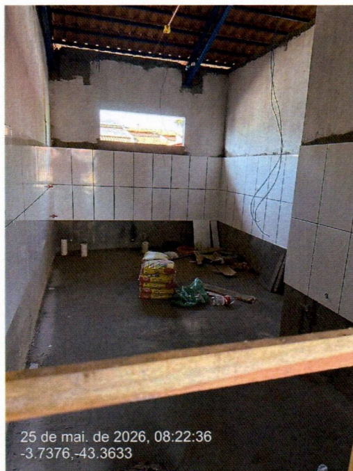
Imagem 14 – Serviços de revestimentos cerâmicos
