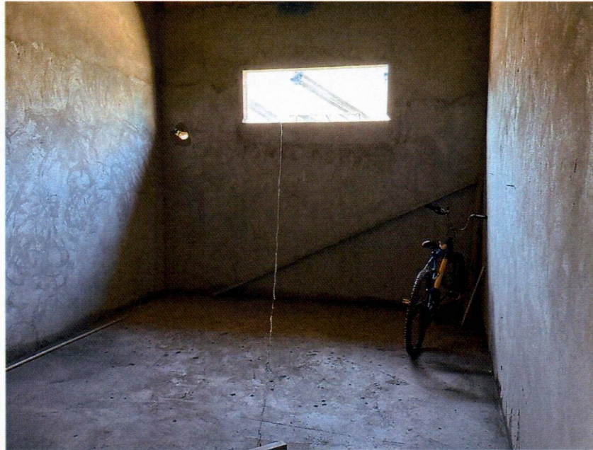
Imagem 02 – Serviços de chapisco e reboco, contrapiso
