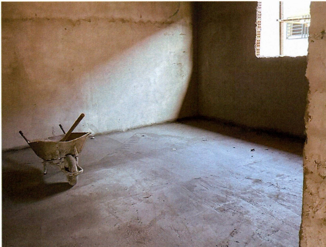
Imagem 01 – Serviços de chapisco e reboco, contrapiso
