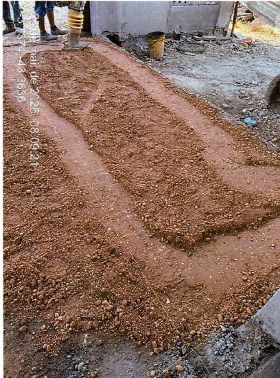
Imagem 04 – Serviços de movimentações de solo, aterro compactado
