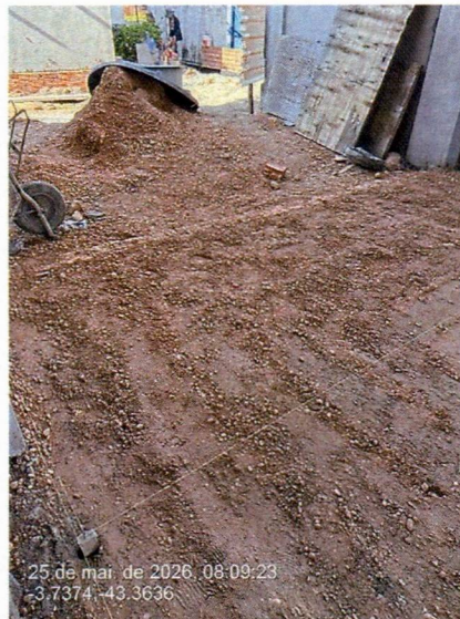
Imagem 03 – Serviços de aterro compactado
