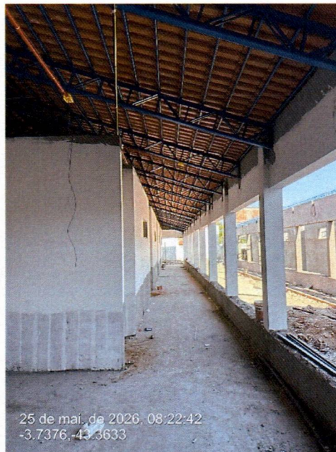
Imagem 2 – Execução das instalações elétricas e execução da pintura interna.
