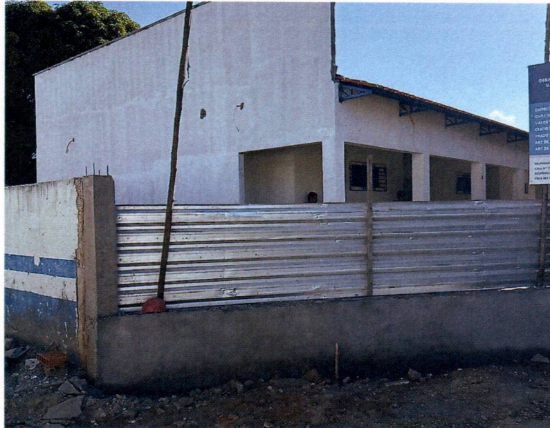
Imagem 16 – Serviços de pintura
