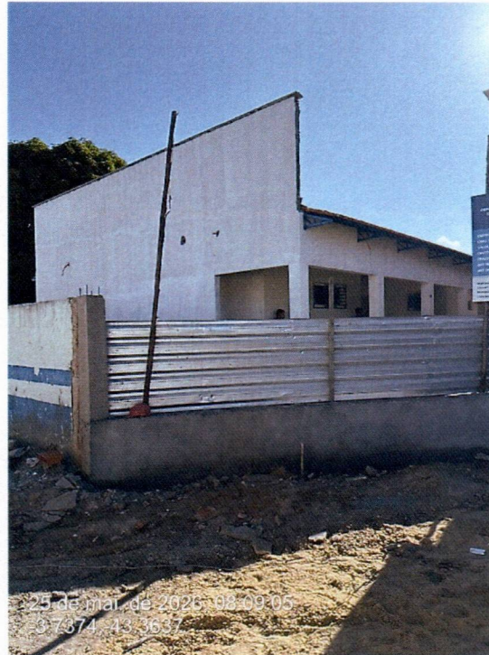
Imagem 7 – Execução da platibanda e aplicação de selador nas paredes externas.
