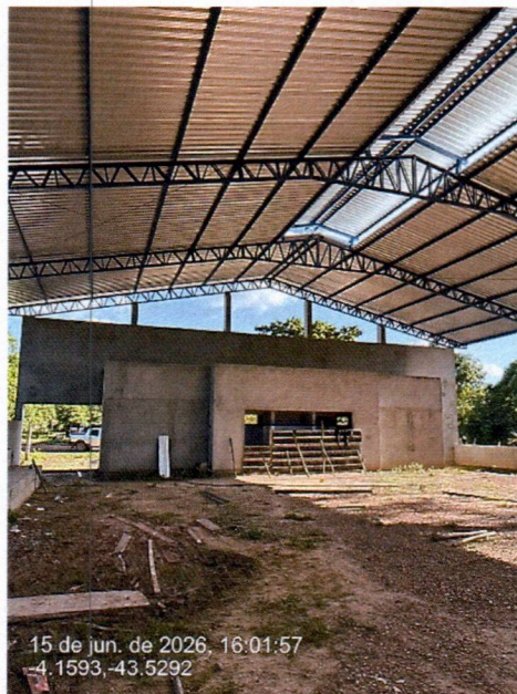
Imagem 2 – Execução da cobertura metálica.
