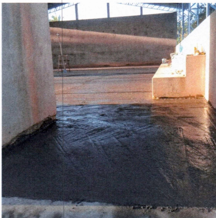
Imagem 15 – Serviços de piso de concreto
