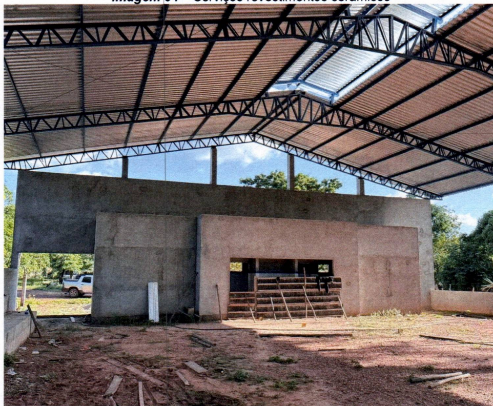
Imagem 05 – Serviços de reboco e cobertura metálica
