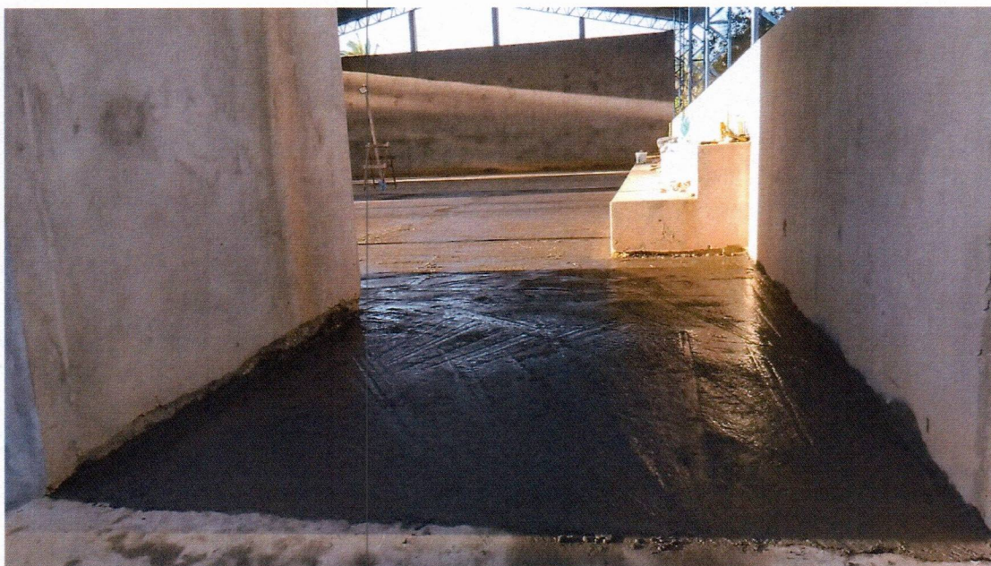
Imagem 9 – Execução da concretagem do piso da quadra.
