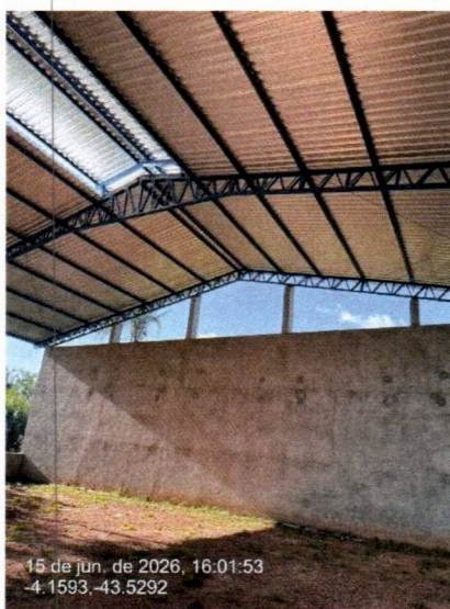
Imagem 03 – Serviços de cobertura metálica
