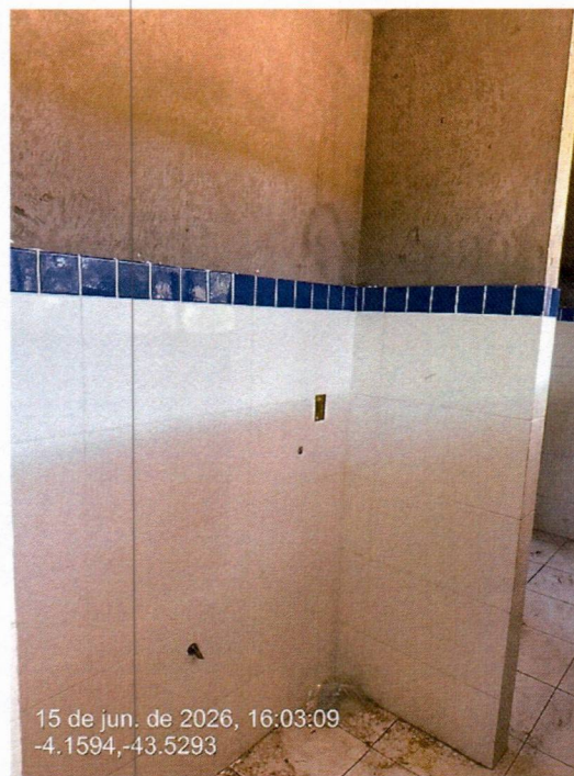
Imagem 8 – Execução do revestimento cerâmico nos banheiros.
