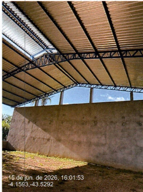
Imagem 1 – Execução da cobertura metálica.
