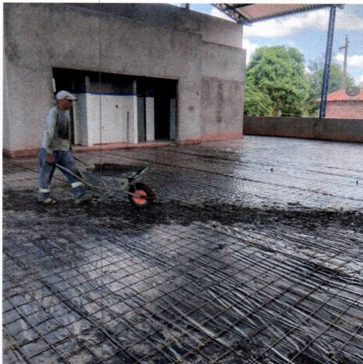
Imagem 16 – Serviços de piso de concreto
