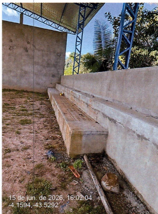
Imagem 6 – Execução da do piso da arquibancada.
