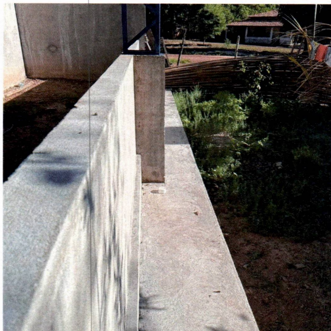
Imagem 12 – Serviços de calçadas
