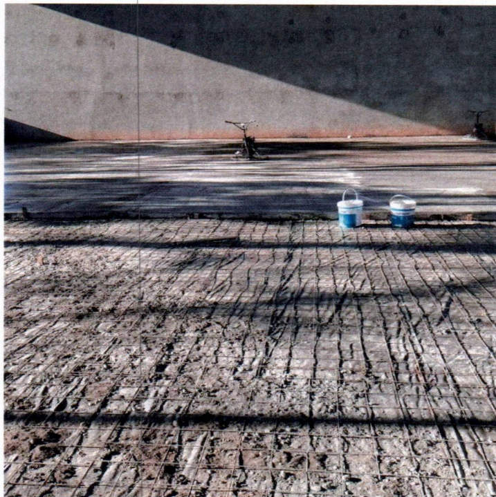
Imagem 14 – Serviços de piso de concreto
