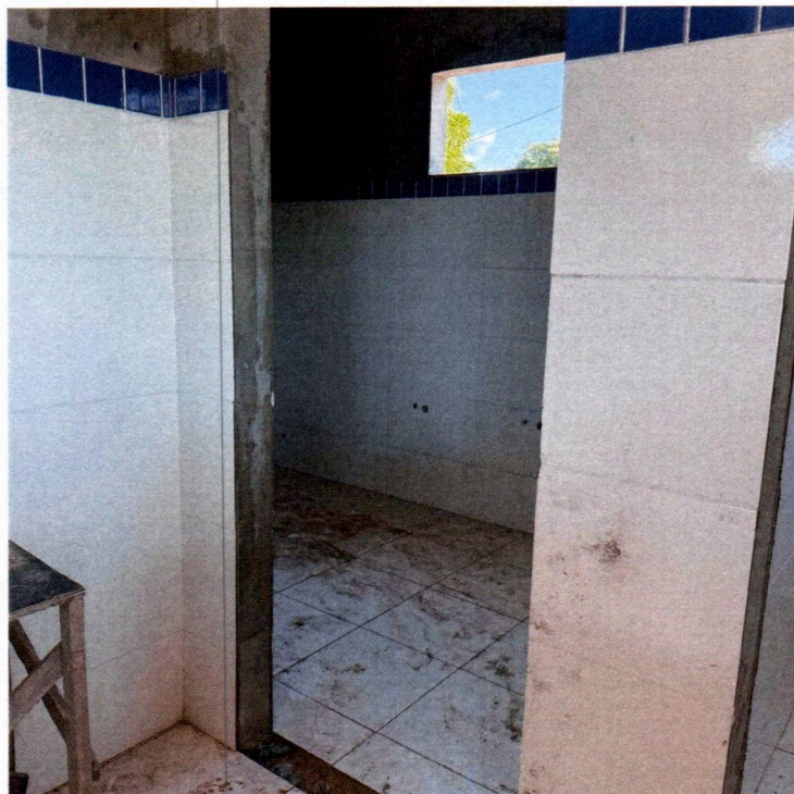
Imagem 08 – Serviços de revestimentos cerâmicos
