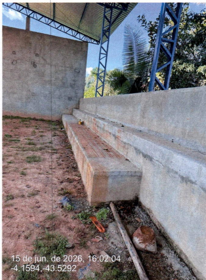
Imagem 01 – Serviços reboco e arquibancadas
