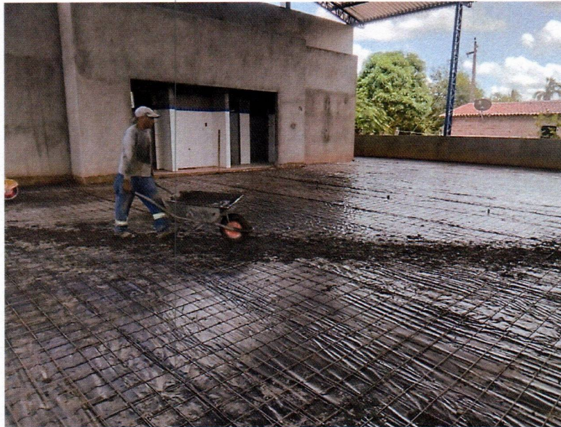
Imagem 3 - Execução do piso da quadra.
