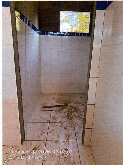
Imagem 7 – Execução do revestimento cerâmico nos banheiros.
