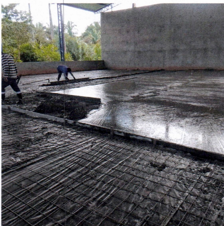
Imagem 17 – Serviços de piso de concreto
